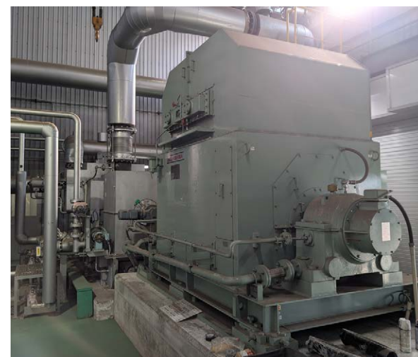
バガスを燃料に電力を生む発電機
